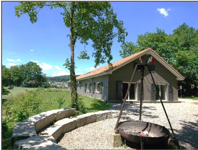
Lagerhaus mit modernstem Innenleben und Solaranlage.
